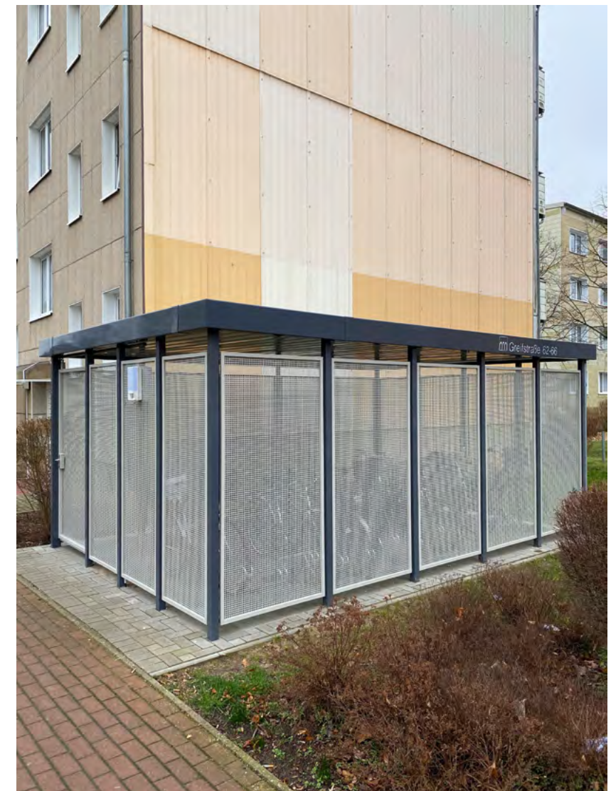
Tür auf und los geht's: In der Greifstraße muss dank neuer Unterstellmöglichkeiten niemand mehr sein Fahrrad in den Keller hieven.
